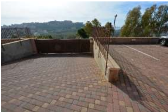
All. 1 - Foto 3 – Ingresso carrabile e pedonale e parcheggio condominiale
