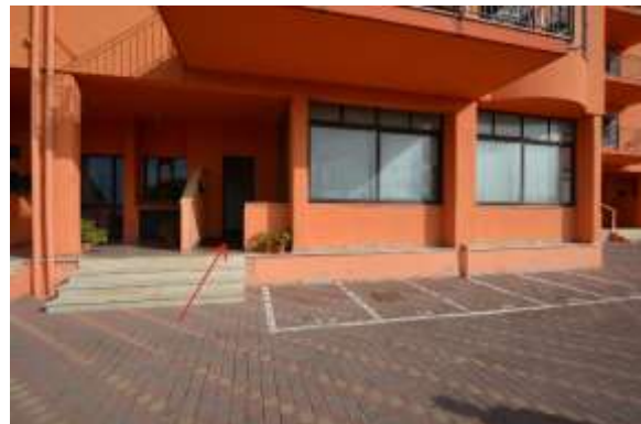
All. 1 - Foto 4 – Ingresso immobile del lotto unico
