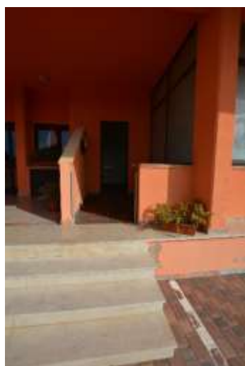
All. 1 Foto 7 – Ingresso ufficio da parcheggio condominiale
